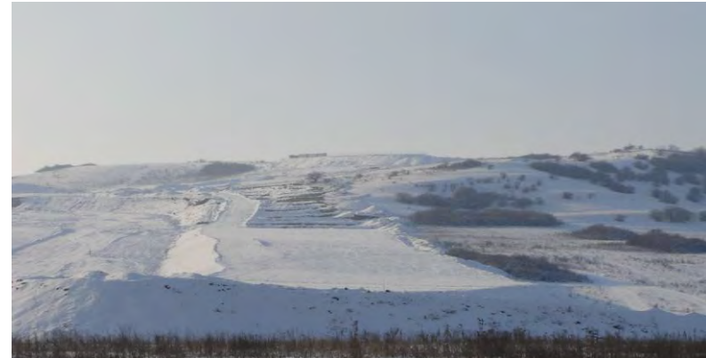
New landfill site
