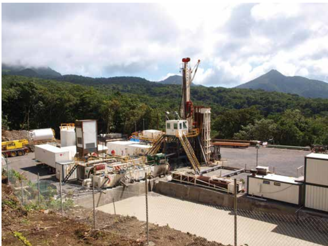
FIGURA 2.3 Plataforma de perforación de tamaño mediano en el Caribe
