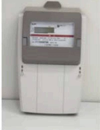
現地設置のスマートメータ
